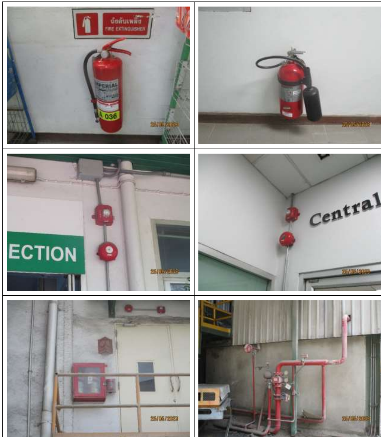
รูปที่ 31 ระบบเตือนภัยและระงับอัคคีภัย
