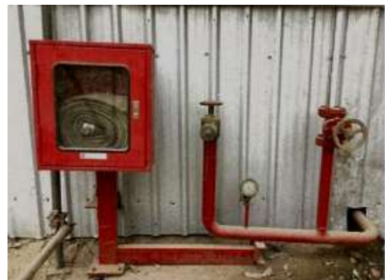
รูปที่ 36 หัวจ่ายน้ำดับเพลิง บริเวณอาคารเก็บเชื้อเพลิง
