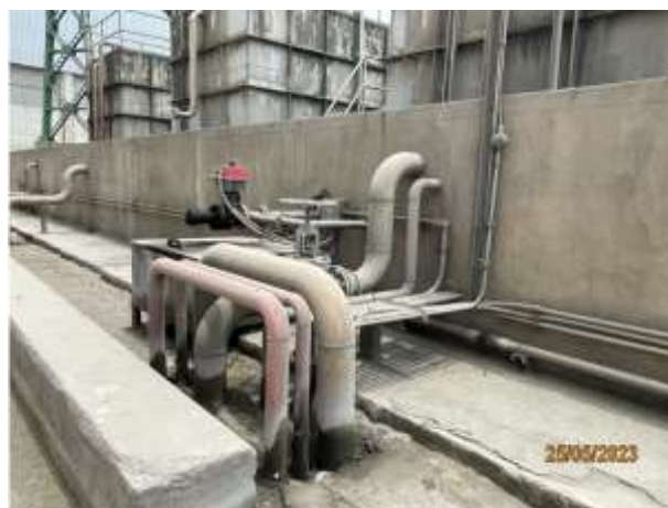
รูปที่ 9 ระบบถัง ท่อลำเลียงและอุปกรณ์สูบน้ำของเสียที่เป็นของเหลว
