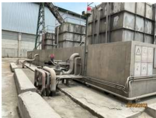
รูปที่ 9 ระบบถัง ท่อลำเลียงและอุปกรณ์สูบน้ำของเสียที่เป็นของเหลว
